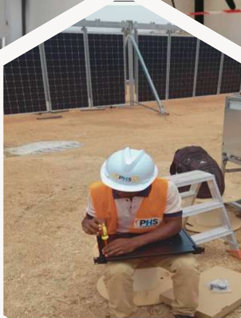
Installation des tiroirs optiques champ solaire
